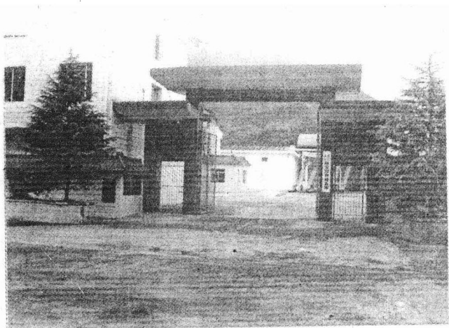
四川南江国家粮食储备库
