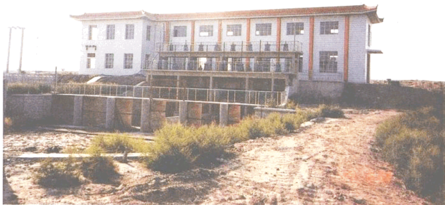
大洼县三角洲水库抽水站
