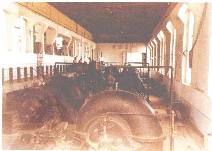
田庄台抽水站
