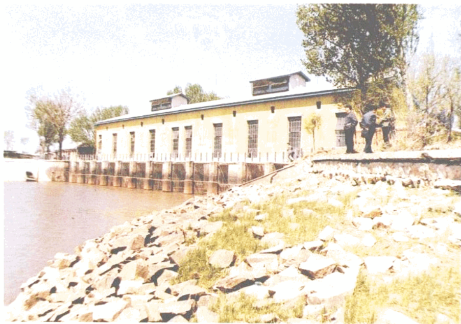
田庄台抽水站前池
