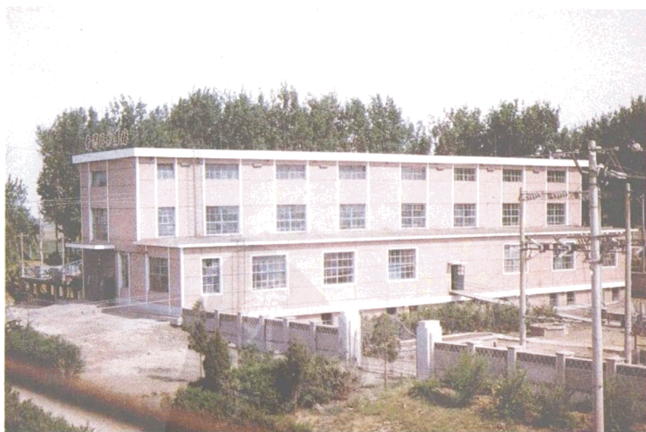
南河沿排灌站厂房
