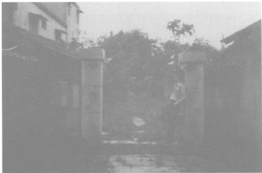
台湾彰化县二林镇李应章保安医院后院通往小溪河的铁门，1949年旧址。
