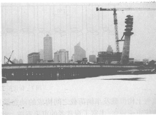
图 10 桥塔钢结构段施工照片
