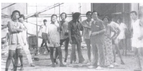
在壁画施工现场
