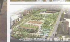
中石油银川能源新城 宁夏 银川 (在建)
