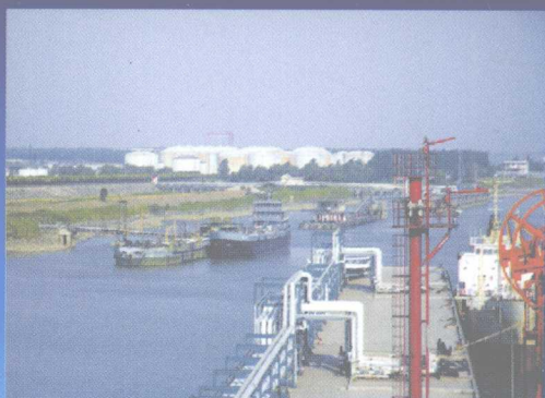
五万吨级的石化码头
