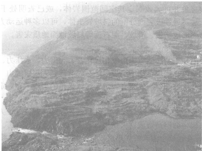
图 1-3 发生于三峡库区的湖北省秭归县沙镇溪镇的千将坪滑坡
