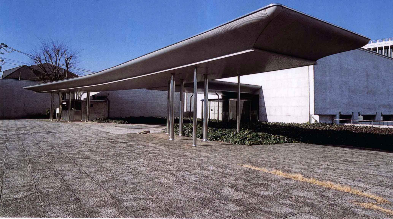
(前) 千代田生命保险总公司大楼的正面玄关(上图)。让人联想起喷射机机翼的天棚, 由林立的不锈钢柱子支撑着。左页图是那些柱子的根部。微微作伸缩喇叭状的柱子和自石板地面突出的石块, 都可见村野先生作品的风貌。
