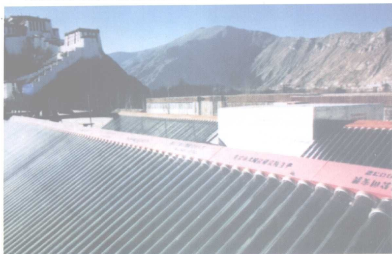
西藏高寒地区的热管式真空太阳热水系统 北京市太阳能研究所供稿
