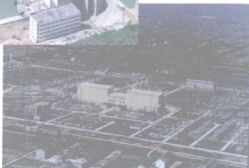
500KV南桥交流、直流变电、换流站鸟瞰图 华东电力设计院供稿
