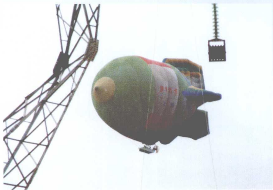
▲飞艇在高压铁塔上空放线（1986年）
