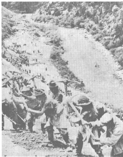
西线筑路民工
