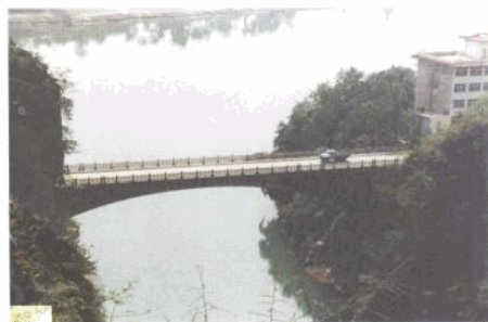
大龙潭风光——峡口大桥 恩施
