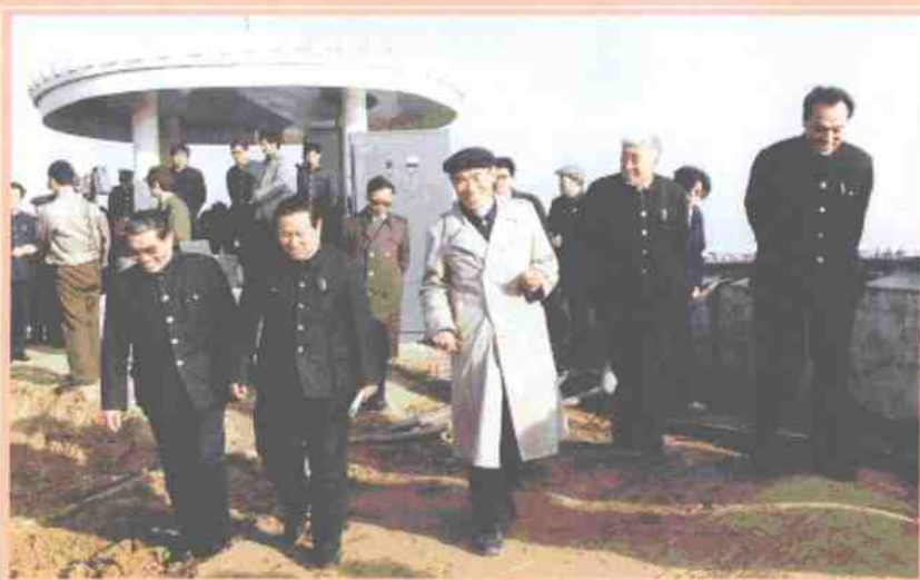
1997年11月，中共山东省委书记姜春云视察中建八局施工的济南“引黄保泉”工程
