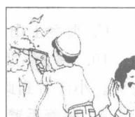
用冲击钻在墙上打孔
