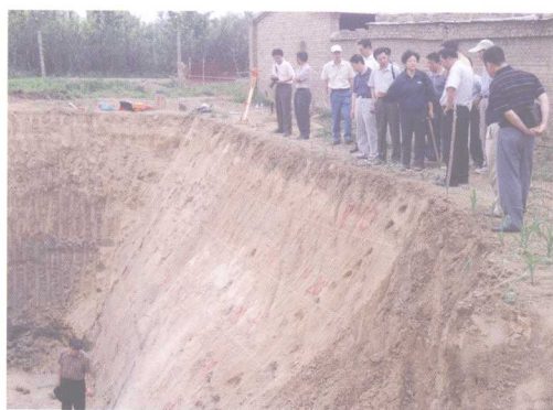
专家学者在顺义西王庄观察地裂缝探槽剖面
