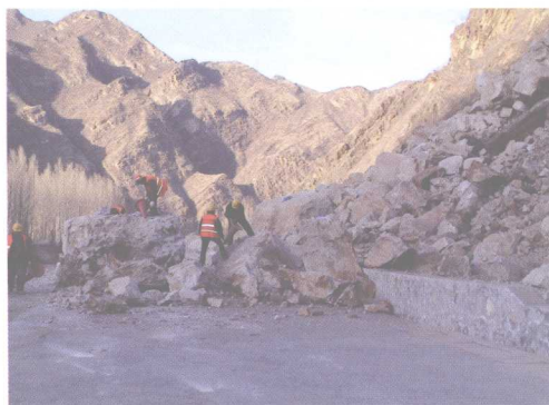
抢险人员正在抢修崩塌损毁的千家店路段
