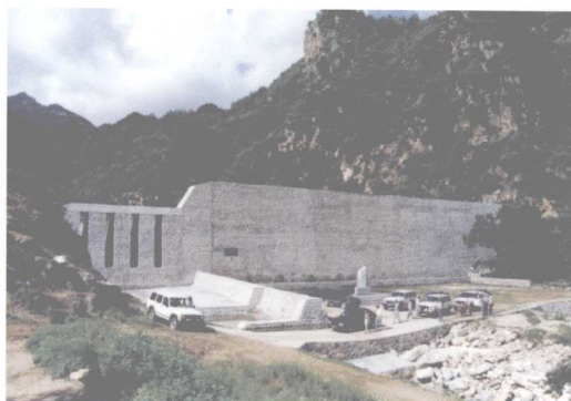
密云番字牌西沟泥石流防治工程
