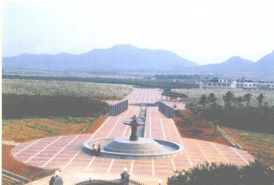
2004 年底,贵溪塔桥园艺场生态农业园一期工程建成
