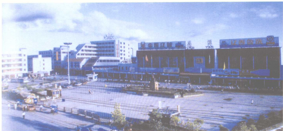
1994 年 10 月,建成投入使用的鹰潭客运站广场
