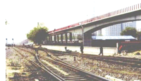
城市轻轨铁路
