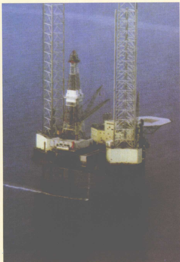
在北部湾北海区中法合作区块作业的南海四号自升式钻井平台。
