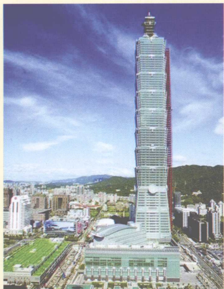
中国台湾 101 大厦像宝塔一样分成 8 个层段，每个层段又由 8 层楼组成。荣获 2004 年“最佳科技成果”之工程。
