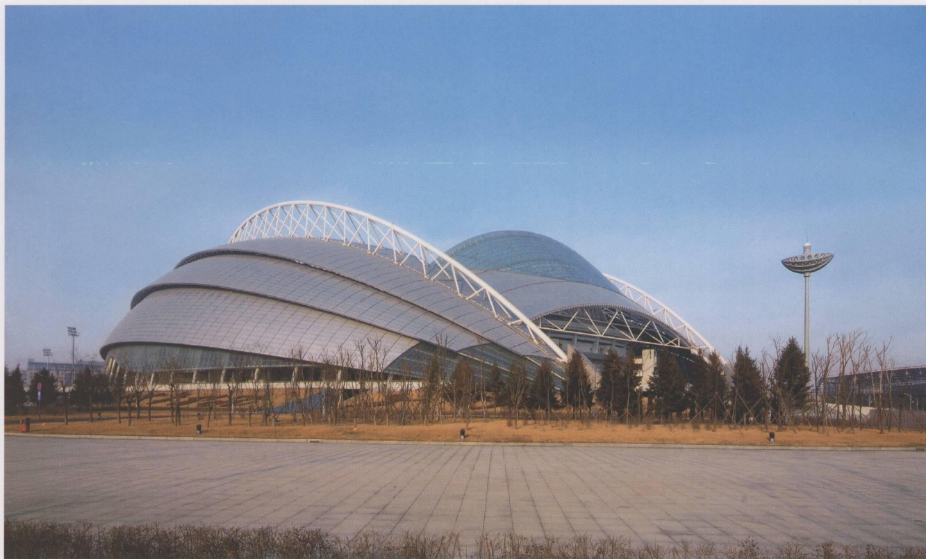
沈阳奥林匹克体育中心体育场 中国建筑一局（集团）有限公司总承包
