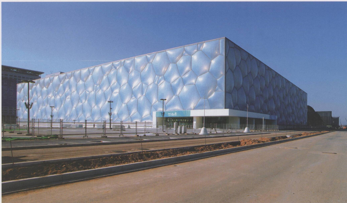
国家游泳中心——“水立方” 中建一局建设发展有限公司总承包
