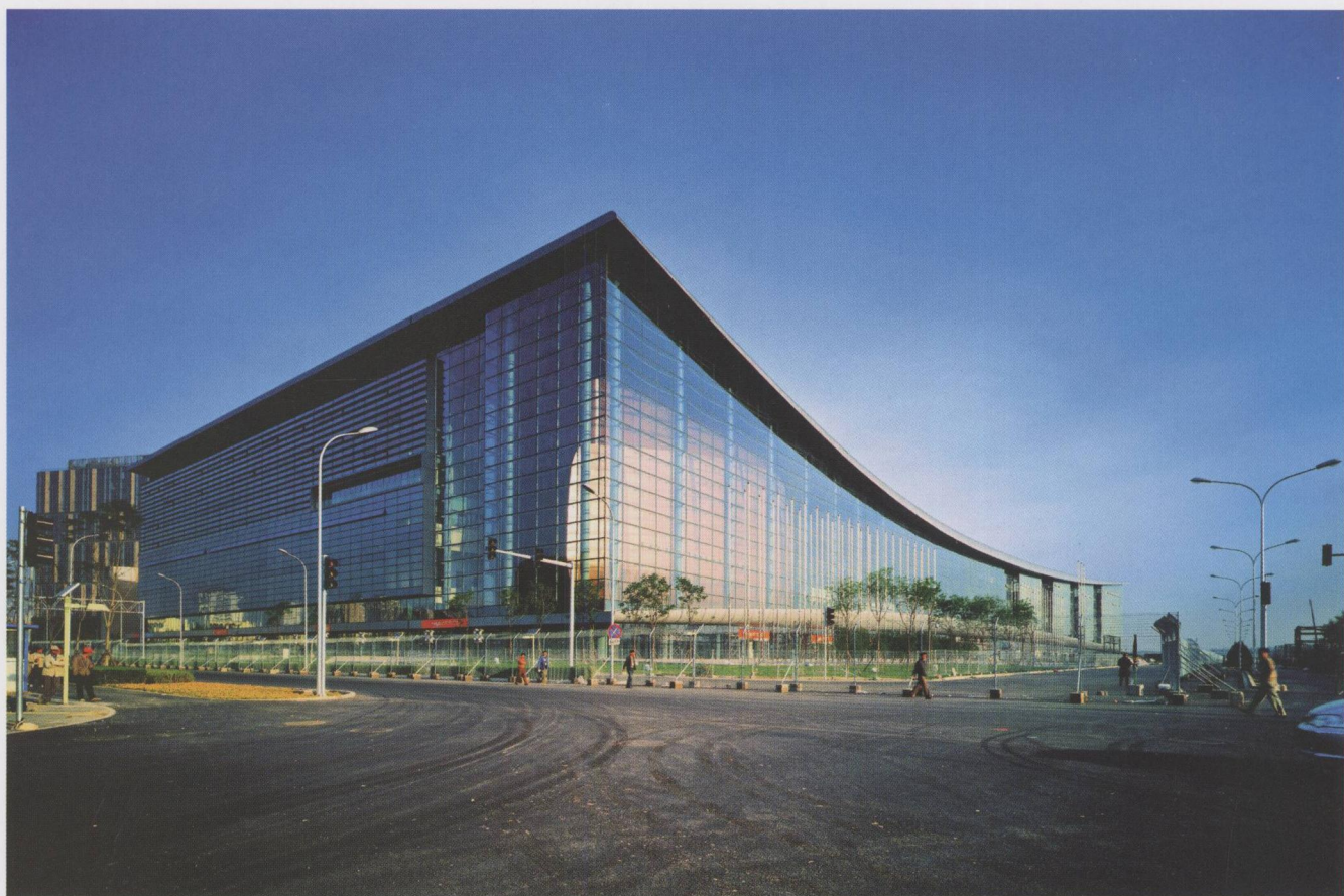
国家会议中心 北京建工集团、中建八局总承包
