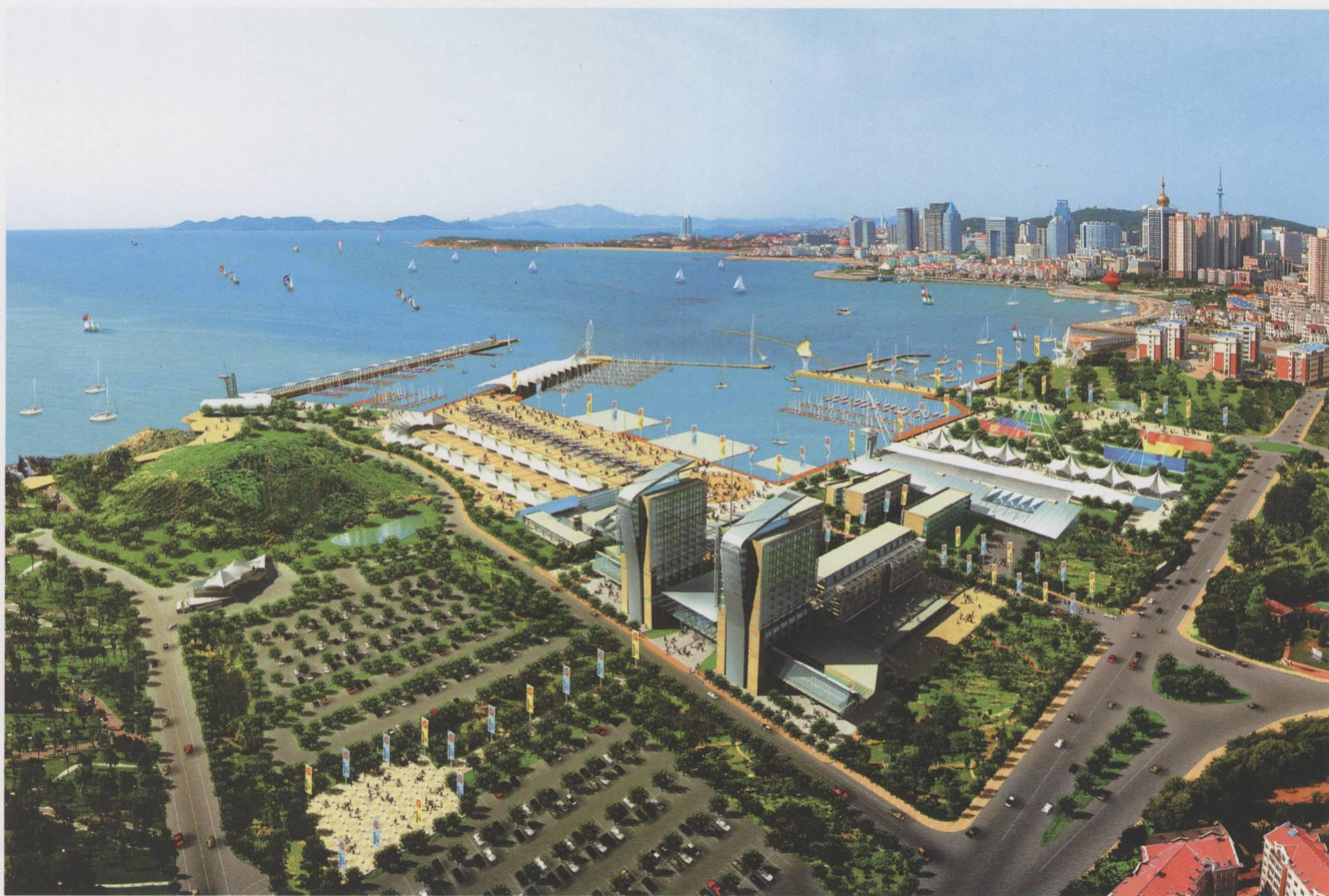
第29届奥运会青岛帆船中心工程 青建集团股份有限公司总承包
