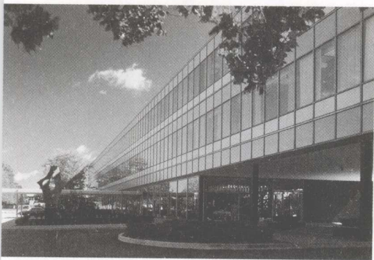
通用汽车技术中心， 沃伦，密歇根州，埃罗·沙里宁，1956年。 用批量生产的预制构件安装的幕墙
