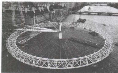
工人在越过河面的临时支撑结构上水平地 装配摩天轮和金字塔形建筑物支撑结构
