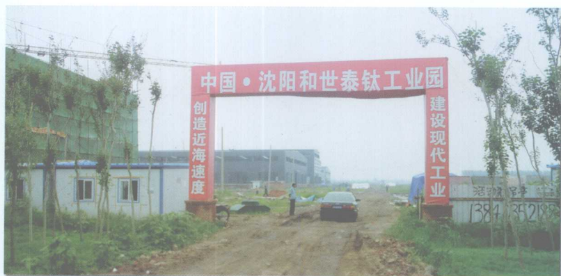
建设中的近海经济区
