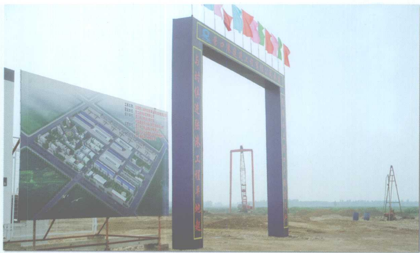
建设中的近海经济区
