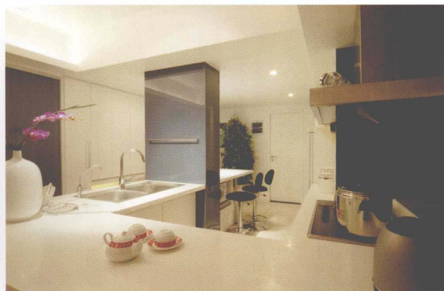
用喷漆玻璃包裹后的水管，自然地厨房与餐厅分离
