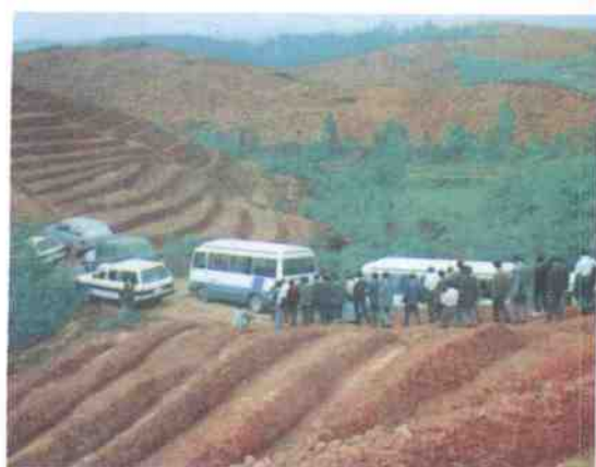
漆河区涌泉乡丘岗开发现场
