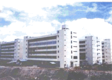
公司開發興建的部分工業廠房。
