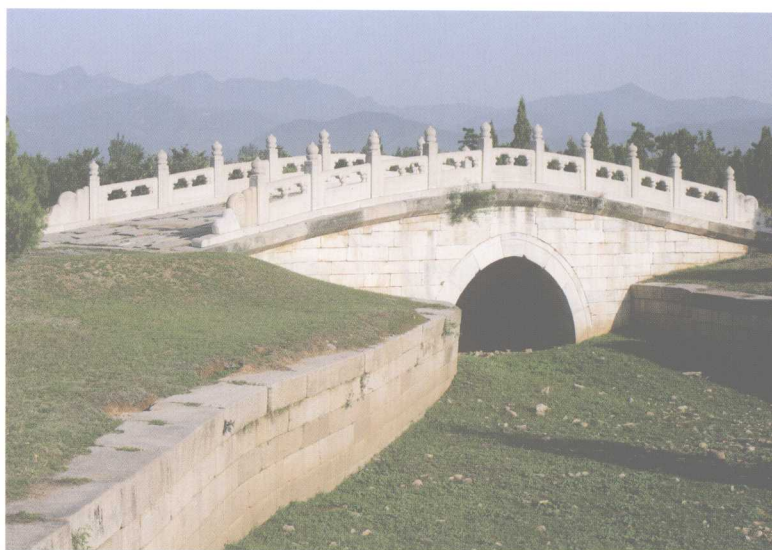
图 12-1 龙凤门北一路——孔石拱桥
