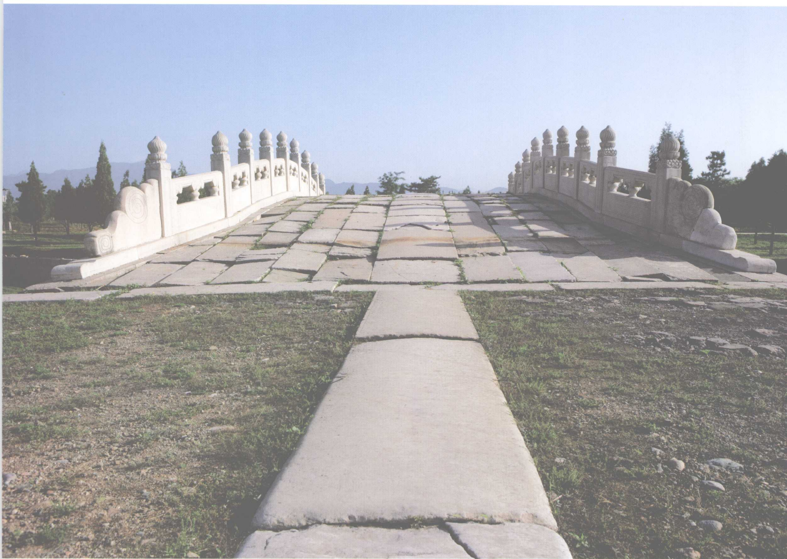
图 12-2 一路一孔石拱桥正面
