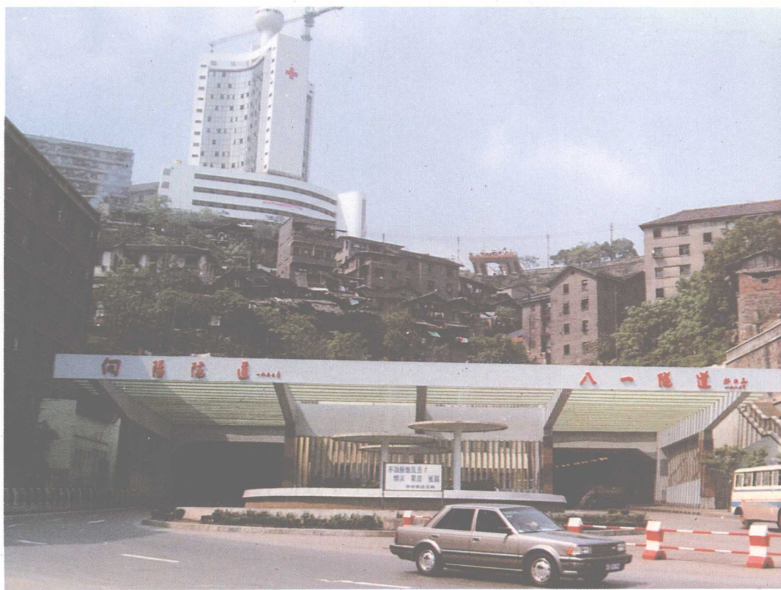
军民合建的八一、向阳隧道
