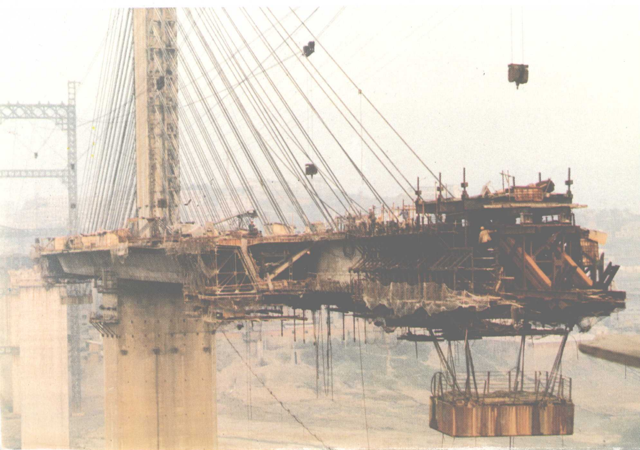
紧张施工中的石门大桥
