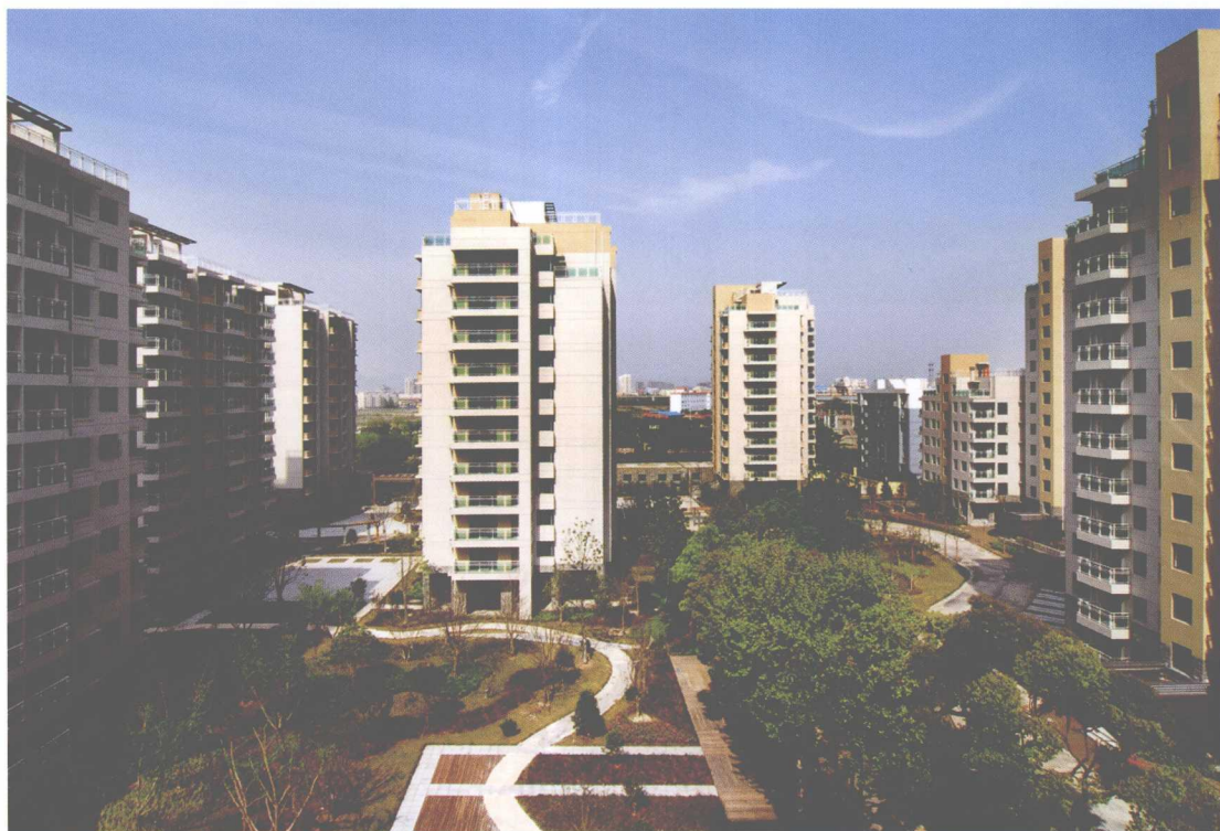
世贸协安“景上公寓”示范工程实景图
