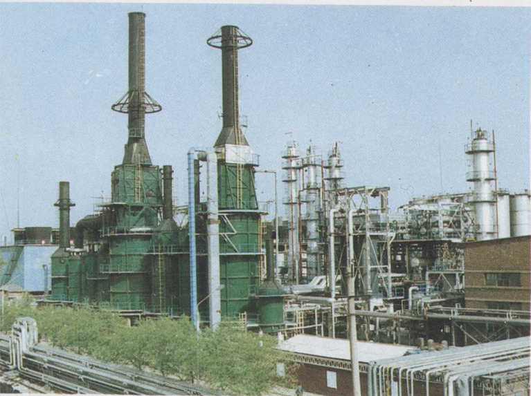
石油一厂是我国燃料油、石蜡和 合成润滑油生产基地。图为该厂铂重 整装置。
