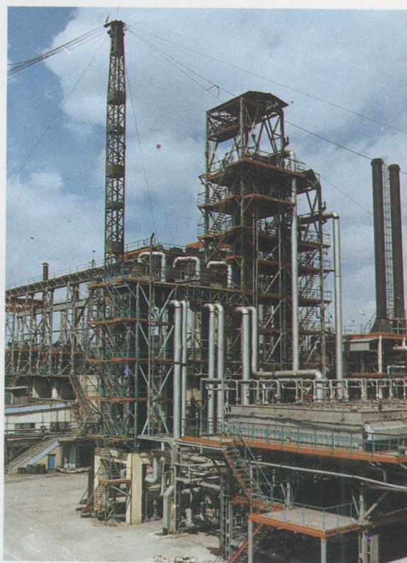
石油三厂是我国 加氢和石油化工催化 剂生产基地。图为 1984年建成投产的加 氢裂化装置。
