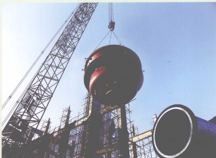
4月19日，南化公司重大技改项目——27万吨/年双加压法稀硝酸装置2台重达87.9吨的氧化炉吊装就位。该设备由南化公司化机厂制作、建设公司吊装。
