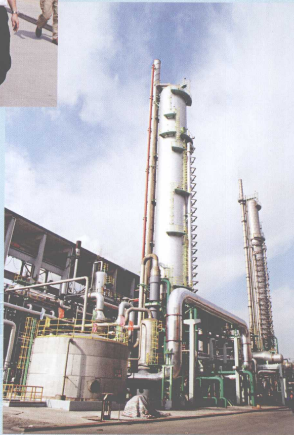
11月24日,南化公司重大技改项目27万吨/年稀硝酸装置实现汽轮机一次冲转成功,标志着新稀硝酸装置全面进入试开车阶段。
