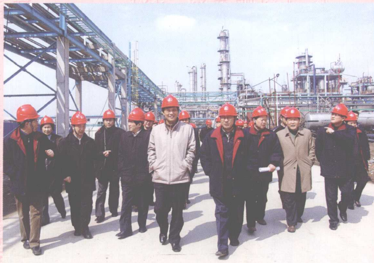
3月5日，南京市工业企业治理搬迁工作调研组来南化公司调研。图为调研组视察南化公司资源优化项目建设现场。
