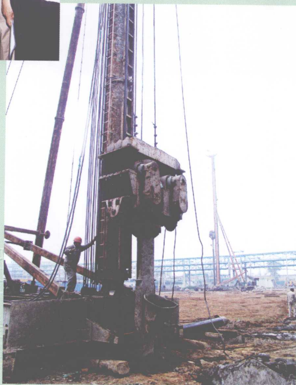
6月1日,0.5万吨/年促进剂CBS装置打桩,标志着南化公司资源优化项目缓建及搬迁装置开工建设。
