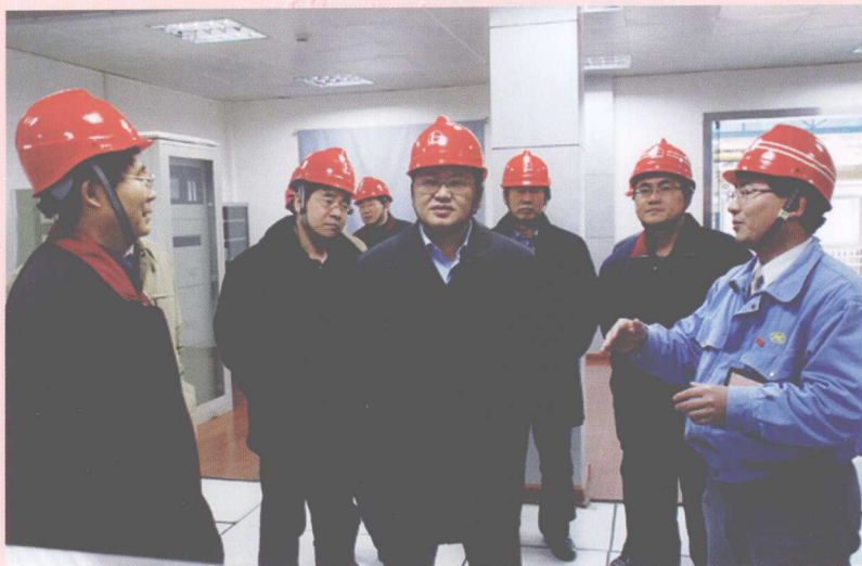
1月21日，中国石化股份公司高级副总裁章建华来公司慰问一线职工和特困职工家庭。图为章建华（图中）视察公司环己酮装置中央控制室。
