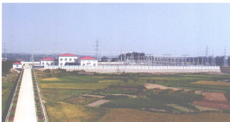
220 千伏观牛变 电所外景
