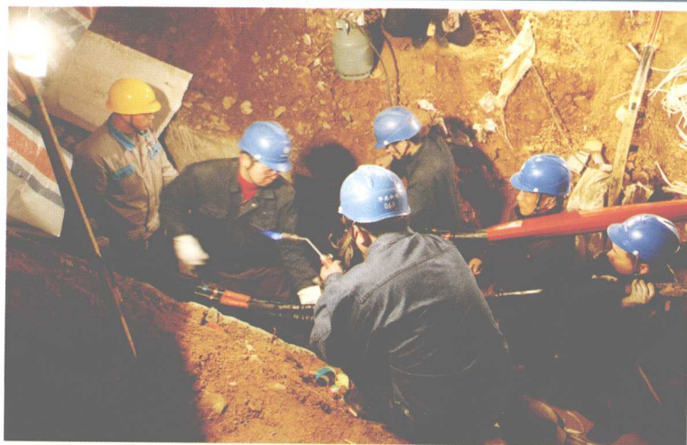
池州供电公司抢修队 夜间为用电客户抢修地下 电缆
