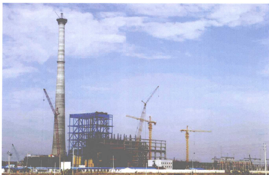
2001 年 5 月，贵池发电厂开始进行锅炉技术 改造，将两台中温中压煤粉炉改造成环保节 能型循环流化床锅炉
