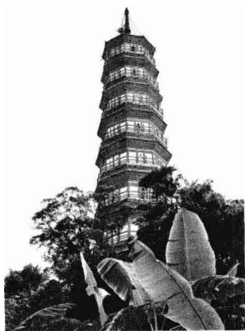
琶洲塔 在琶洲村。此处原是江中小岛，因山似琵琶，塔建山上，故名。又名海鳌塔。清代羊城八景之一的“琶洲砥柱”即指该塔一带风景。建于明代万历二十八年（1600）。现为广东省文物保护单位。
