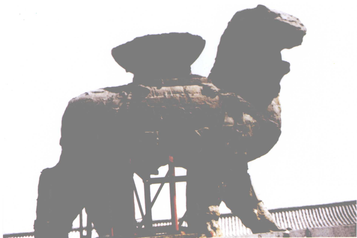
1994年，实施内支撑保护后的铁狮子
