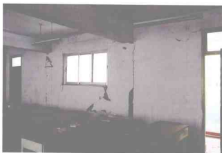
1.1.8 汶川威州某砖混结构住宅两道变形缝使各单元独立,震后基本完好 (李力 摄)
