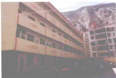
1.1.3 汶川威州某砖混结构教学楼, 滑坡威胁严重 (李力 摄)
