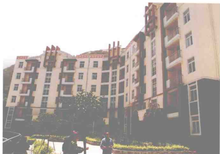
1.1.8 汶川威州某砖混结构住宅两道变形缝使各单元独立,震后基本完好 (李力 摄)
