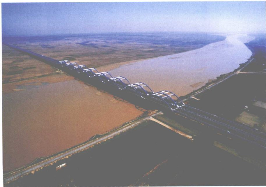
▲ 京港澳高速公路黄河大桥
