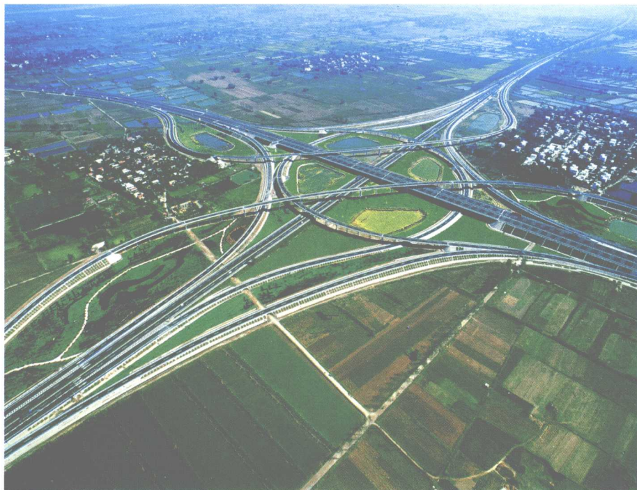
▲ 京港澳与连霍高速公路互通刘江立交桥
