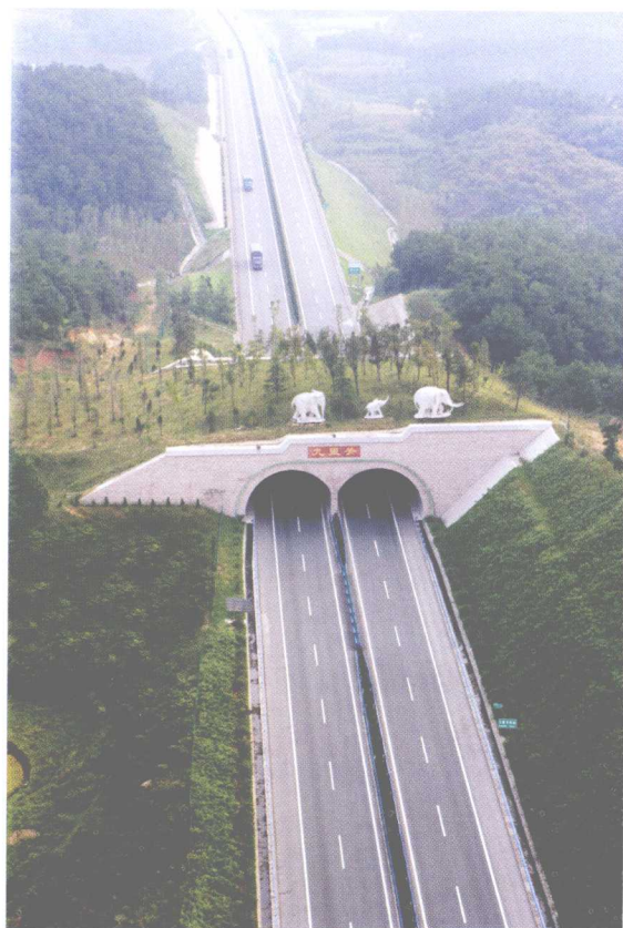
▲ 京港澳高速公路豫鄂界九里关隧道
