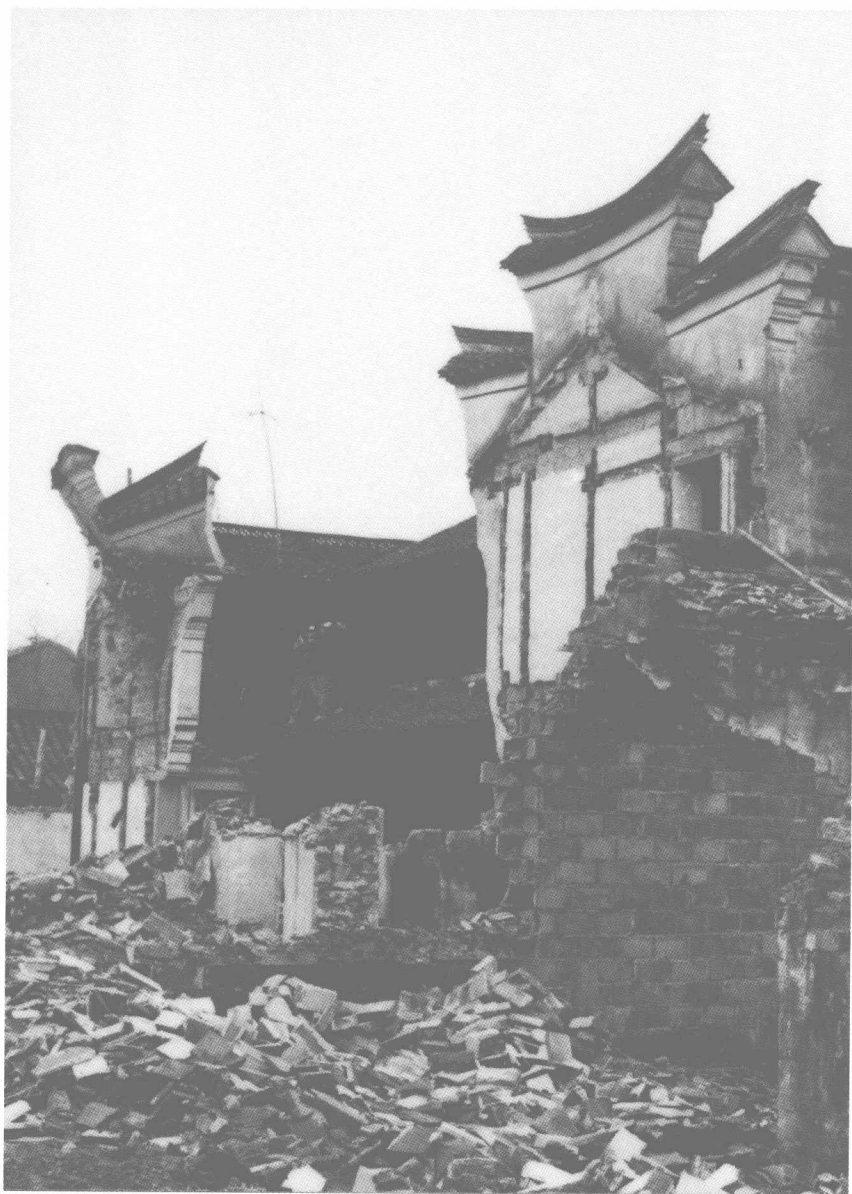
拆除中的定海金家大屋马头墙（1998年1月8日）
