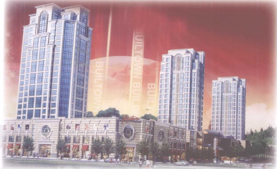
【即将建设的百通大厦】
