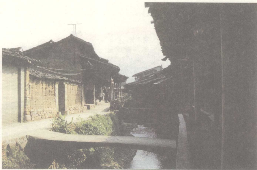
▲ 在中国,您随便走进一个小村,便可以看到其建筑布局
