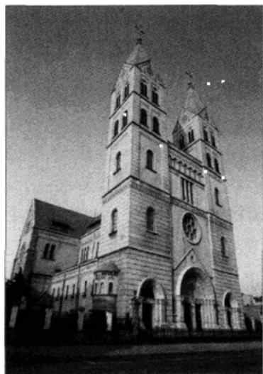
【浙江路天主教堂】位于市南区浙江路北端，为钢筋混凝土与花岗石结合筑成。教堂两侧各耸立一座钟塔，顶尖各竖有高 4.5 米的巨大十字架，楼高共计 60 余米。教堂内大厅可容纳千余人。
