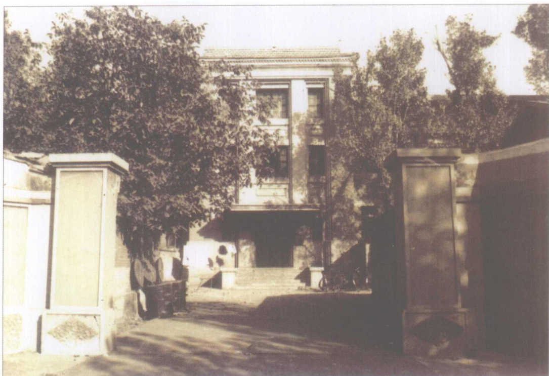
中国人民银行总行旧址（小灰楼）
