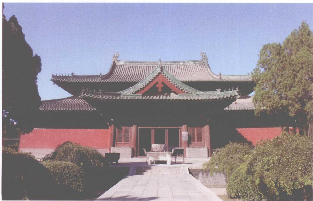
隆兴寺摩尼殿
