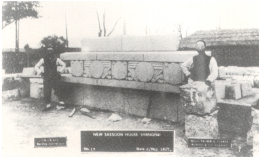
图 1.37 中国工匠和他们所完成的沙逊大厦（今和平饭店北楼）墙身上的水平带状石雕装饰。当时的上海工匠十分聪明、十分认真，他们根据设计师提供的图片或草图，先由木匠做出木制模型，经过几次反复修改，得到认可后做出足尺木制模型，最后再由石工雕成正品。有些建筑中的雕刻甚为复杂，他们也能如原样，甚至超过原样精美地做出来。
