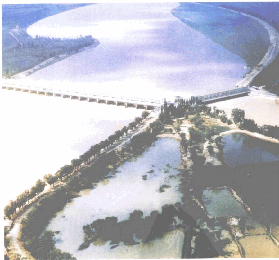
黄河三盛公水利枢纽工程
