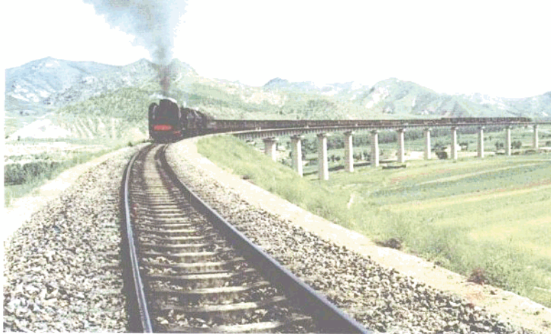
集(宁)通(辽)铁路贯通内蒙古草原腹地
