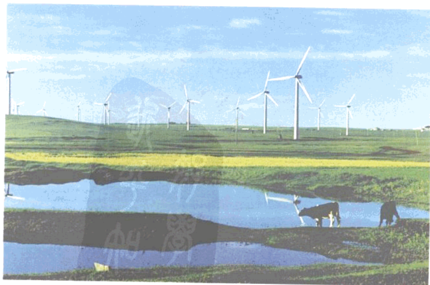
地处草原深处的辉腾锡勒风力发电场
