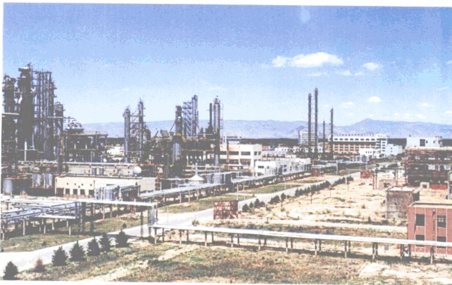
国家重点建设工程——华北石油管理局呼和浩特市炼油厂
