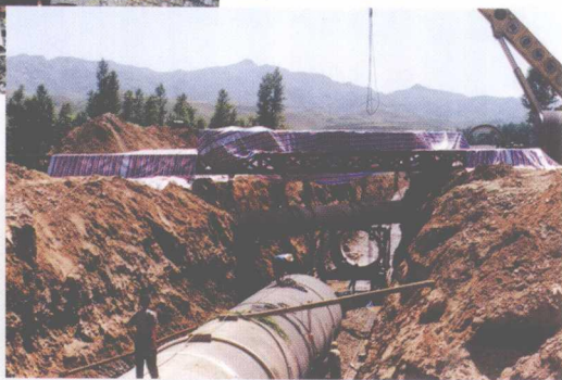
PCCP 穿越其他管道施工
