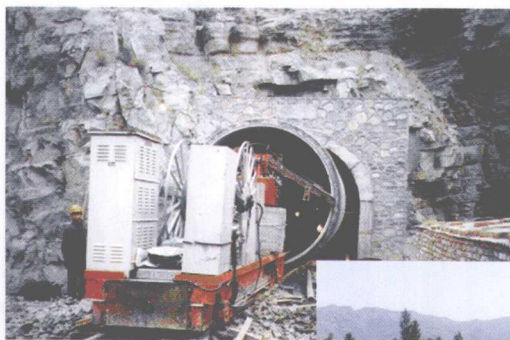
隧洞内铺设 PCCP 施工
