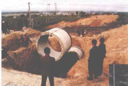
PCCP 穿越铁路顶管施工
