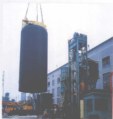
喷浆完成后的PCCP
