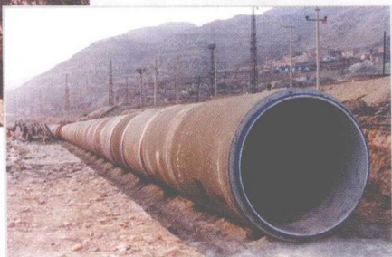
安装就绪的 PCCP
