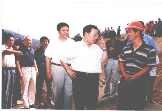
引黄工程管理局王新义局长陪同山西省省委书记田成平、常务副省长范堆相视察工地
