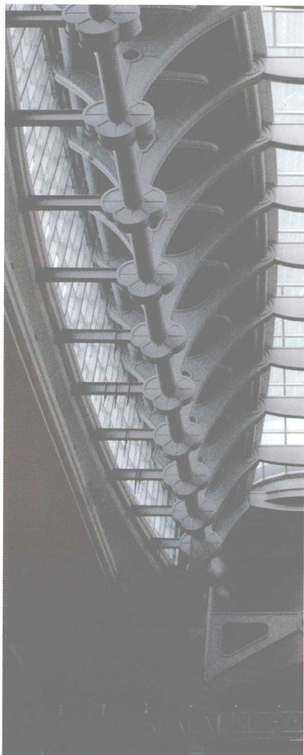
图 1.6 中国台北 101 大厦裙楼中庭梁构
