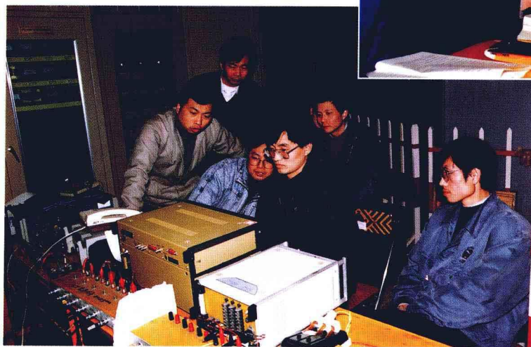
▲变电所现场调试
