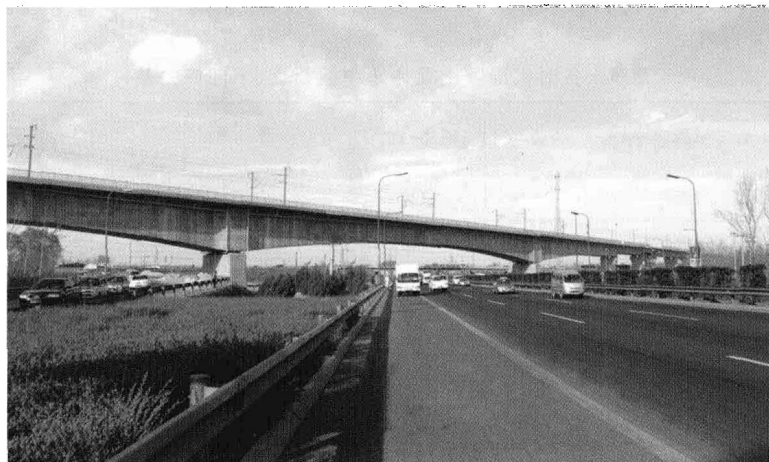
图 7 跨北京五环路 128 m 混凝土连续梁桥
