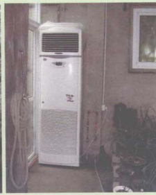
水冷机，利用地下水冬暖夏凉的特点来调节温度
