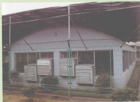
大型兰房外墙装置水帘机
