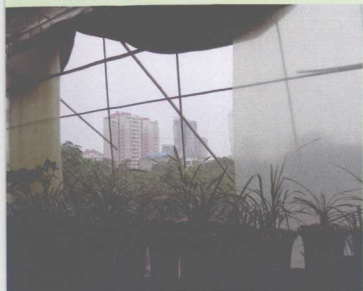
防护栏向外延伸，用阳光板做简易可推拉式的半封闭阳台
