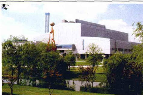
上海江桥生活垃圾焚烧厂是一座设计新颖、设备先进的花园式厂房，建成时成为国内规模最大、技术最先进的生活垃圾焚烧厂。（2004年获奖）
