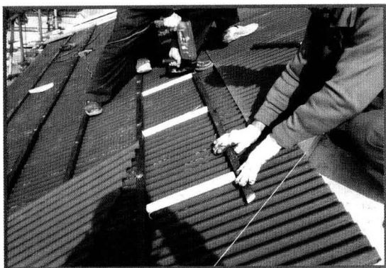
铺设波形沥青防水板
