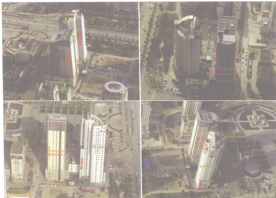
图2-15 广西南宁五象广场某建筑东、南、西、北四个方向的斜片三维量测
